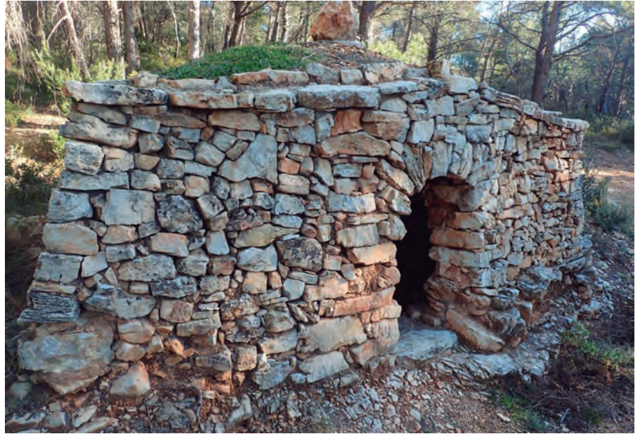
A la carretera de Farena, prop del Pinetell, hi ha una altra cabana de pedra seca en un òptim estat de conservació.
