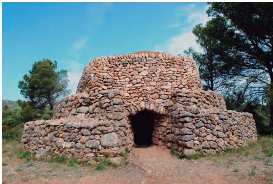
La barraca Jaume de la Cota, a Mont-roig del Camp, és un clar exemple de construcció en pedra seca.
